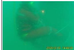
Proses menempatkan posisi anoda di pile sampai pengelasan
