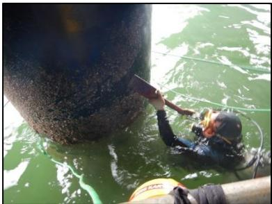
1. Persiapan permukaan: Permukaan dibersihkan terlebihkan dahulu dari sisa kerak, korosi atau material dengan standard SSPC-SP2/3 (Hand Tools / Power Tools).
